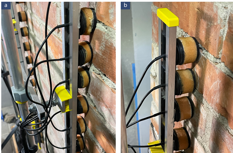
Rys. 5.10. Widok elektrod przyłożonych do powierzchni muru ceglanego: (a) widok obu listew z elektrodami, (b) widok górnej części lewej listwy
